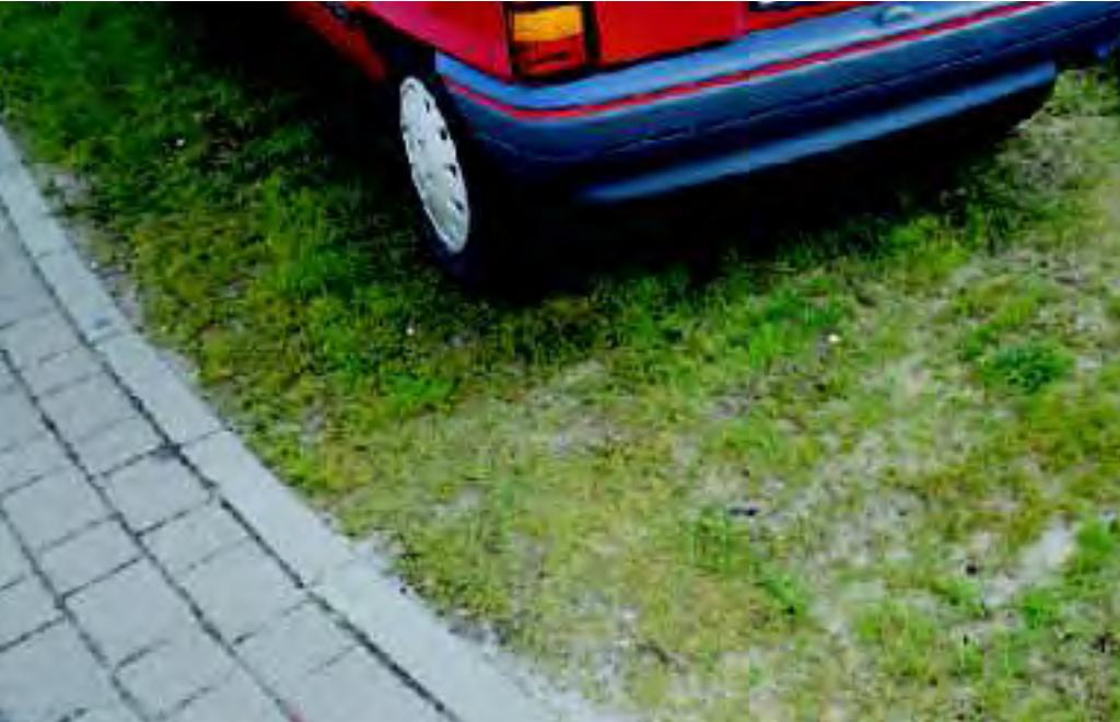
Schotterrassen besteht aus einem verdichtetem Gemisch aus Schotter und Mutterboden, das mit Gräsern bewachsen ist.
