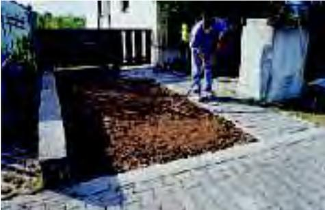
Nachdem alle Bestandteile der Befestigung vollständig entfernt sind, wird der Mutterboden aufgebracht. Dieser sollte etwas höher aufgefüllt werden als notwendig, weil er sich mit der Zeit setzt. Achten Sie darauf, dass lockerer, humusreicher Boden geliefert wird, der keine Steine oder Grassoden enthält.
