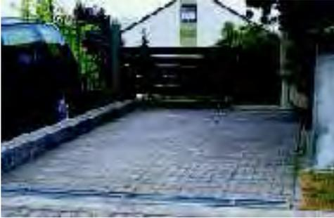
Zuerst wird die Oberfläche gelockert, bzw. die Pflastersteine werden nach und nach entfernt. Achtung! Pflastersteine halten nur deshalb gut zusammen, weil sie im sogenannten Verbund liegen. Daher die Steine vom Rand abnehmen, ggf. die Randbefestigung vorher entfernen. Die Steine können vielleicht woanders wieder verwendet werden. Erkundigen Sie sich bei der Firma, die den Container stellt oder bei Ihrer Kommune.
