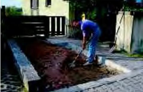
Stellen Sie eine möglichst ebene Fläche her, die etwa 20 Zentimeter tiefer ist als die Höhe der gewünschten späteren Oberfläche (Erdaushub oder Entfernen des alten Befestigungssystems).
