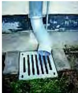
Zuletzt wird ein passender Bogen auf das Fallrohr gesteckt und mit einer Schelle am Gebäude befestigt. Das Regenwasser fließt nun gezielt in den Hofablauf. War das ursprüngliche Standrohr relativ hoch, muss ggf. vorher noch ein Zwischenstück in der richtigen Länge eingepasst werden.
