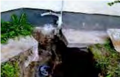
6. Dann wird die Zuleitung zur Mulde gebaut, indem zunächst die Erde im Bereich des Standrohres der bisherigen Regenwasserableitung aufgedrückt und das Standrohr entfernt wird.
