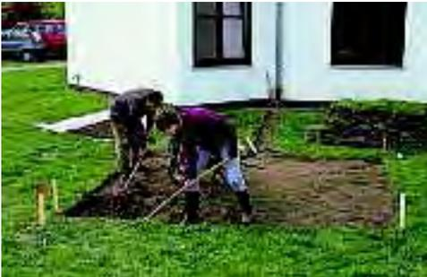
3. Der anstehende Mutterboden wird nun ebenfalls ausgehoben und seitlich gelagert, da er später wieder eingebaut wird.
