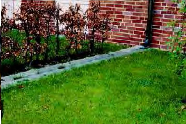
**Abkopplung von undurchlässigen Oberflächenbefestigungen.**
