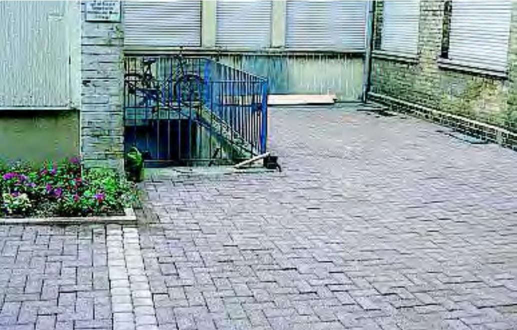
Porenpflaster besteht aus großporigen wasserdurchlässigen Betonsteinen.
