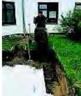
Die eigentliche Rigole ist nun fertig und es wird mit der Verfüllung des Bodens begonnen. Bringen Sie den Boden in mehreren Schichten in die Baugrube ein und verdichten Sie ihn lagenweise.
