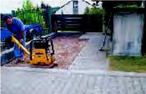
Füllen Sie jetzt zirka 15 Zentimeter Kies oder Schotter locker auf. Die Oberfläche muss eben, evtl. mit dem gewünschten Gefälle hergestellt werden. In Abhängigkeit der späteren Belastung ist die Fläche mit einem Stampfer (Gehweg, Abstellfläche) oder Flächenrüttler (Kfz-Stellplatz, Fahrweg) zu verdichten. Während des Verdichtens ist die Fläche öfters zu glätten und ggf. aufzufüllen, bis eine ebene Fläche in der gewünschten Höhe entstanden ist.
