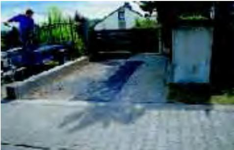
Jetzt wird der Kies bzw. Splitt mit der Körnung 2/8mm auf die verdichtete Fläche locker in der Schichtdicke von zirka 5 bis 6 Zentimeter aufgebracht, verdichtet und glattgeharkt.
