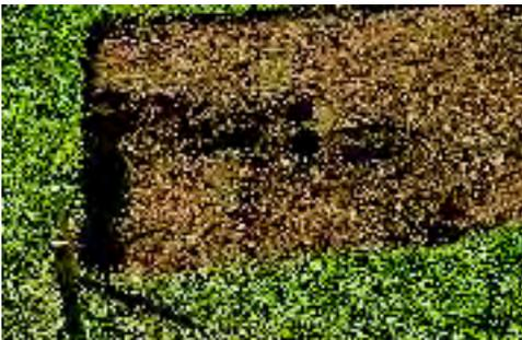
4. Der unter dem Mutterboden befindliche Untergrund wird bis in eine Tiefe von 25 Zentimetern (Muldentiefe) ausgehoben. Der Boden wird entsprechend den Möglichkeiten auf dem Grundstück verwertet oder abgefahren.
