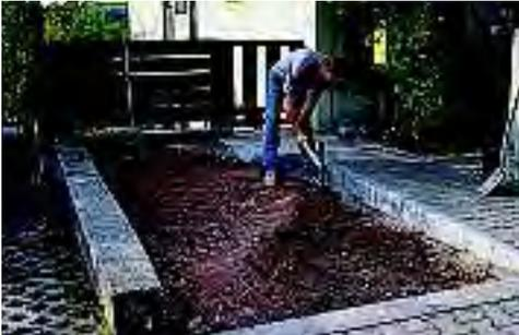
Das Material, das unter der bereits entfernten Oberfläche liegt, wird jetzt bis zum natürlich gewachsenen Boden ausgehoben, in einen Container gefüllt und ordnungsgemäß entsorgt. Falls erforderlich, sind Randbefestigungen abzutragen bzw. neu herzustellen.
