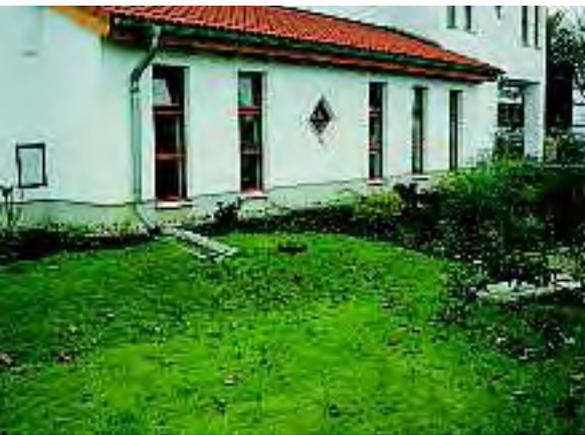
Regenwasser, das von versiegelten Flächen abfließt, kann in vielen Fällen gezielt in den Boden versickert werden. Das Wasser wird dem Boden über Mulden, Schächte oder sogenannte Rigolen zugeführt. Es handelt sich hierbei um Regenwasser von Dachflächen oder aus dem Überlauf von Regenwasserspeichern. Die gezielte Versickerung von Regenwasser wird auch in Fällen angewendet, in denen der Austausch von wasserundurchlässigen Oberflächenbefestigungen zu teuer bzw. zu aufwändig ist.
