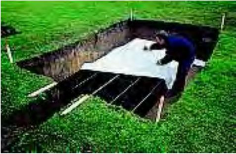
Die Kunststoffelemente werden mit dem Filtervlies an der Oberfläche und an den Seiten abgedeckt. Das Vlies sollte auch einige Dezimeter im Bereich der Sohle des Arbeitsraumes aufliegen. Besonders sorgfältig müssen Sie im Bereich des Zulaufs arbeiten, es darf später an keiner Stelle von außen Boden in die Rigole einrieseln.
