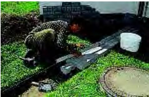
9. Dann wird ein passender Bogen auf das Fallrohr aufgesteckt und an dem Gebäude mit einer Schelle befestigt. Somit kann das Regenwasser gezielt in die Ableitungsrinne abfließen. War das ursprüngliche Standrohr relativ hoch, muss ggf. vorher noch ein Zwischenstück in der richtigen Länge eingepasst werden.
