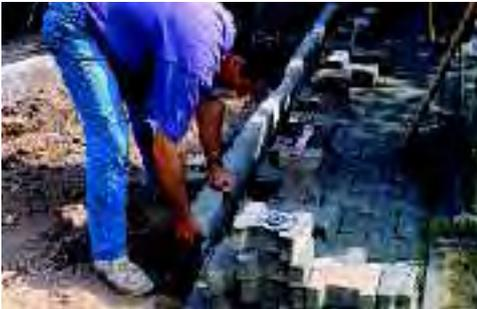
Falls die Fläche eingefasst werden soll, setzen Sie jetzt die Randsteine in ein Kiessand-Zementgemisch. Damit die Einfassung gerade wird, spannen Sie eine Schnur. Achtung, die Höhenlage der späteren Fläche wird hierdurch festgelegt. Achten Sie darauf, dass die Anschlüsse an benachbarte Flächen passen.
